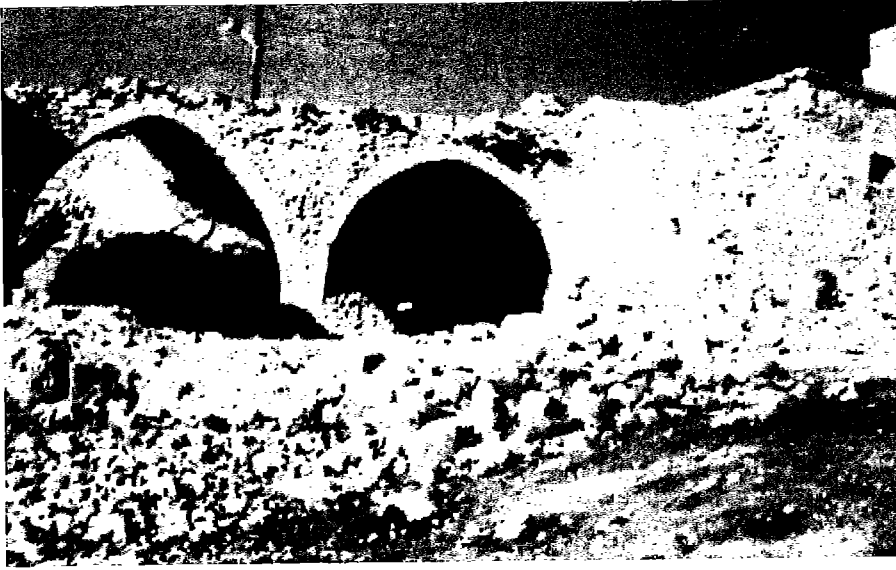
الأقواس التي تحمل السقف لأحد البيوت القديمة في كفرخل تعود للعهد العثماني
