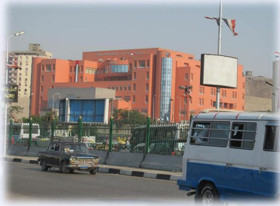
لقطة للمبنى من الشارع الرئيسي المزدهم بوسائل المواصلات تبين صعوبة دخول المرافق
