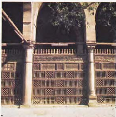
مسجد الطنبغا المارداني الحجاب الخشبي الذي يفصل بيت الصلوة عن الصحن - القاهرة.
