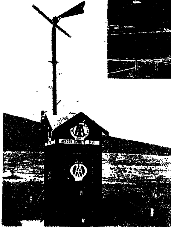
مولد كهربائي يعمل بواسطة الريح
