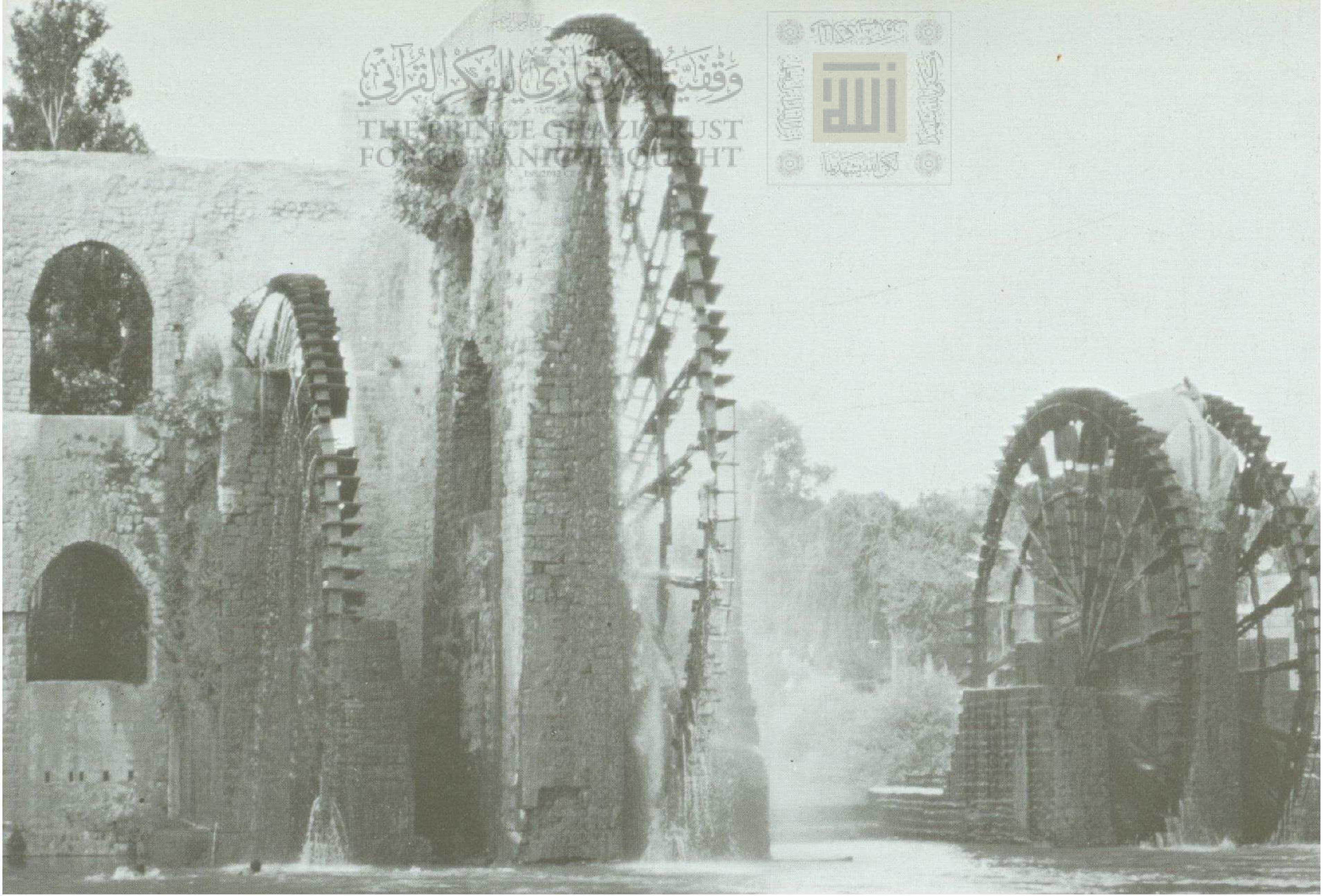
١٣٤ هذه العجلة الضخمة تمثل عجلة ناعورة عظيمة من حماة ، سوريا . والناعورة ولو أنها رومية الاصل فانها لا تزال موجودة حتى يومنا هذا وخاصة بسوريا .
