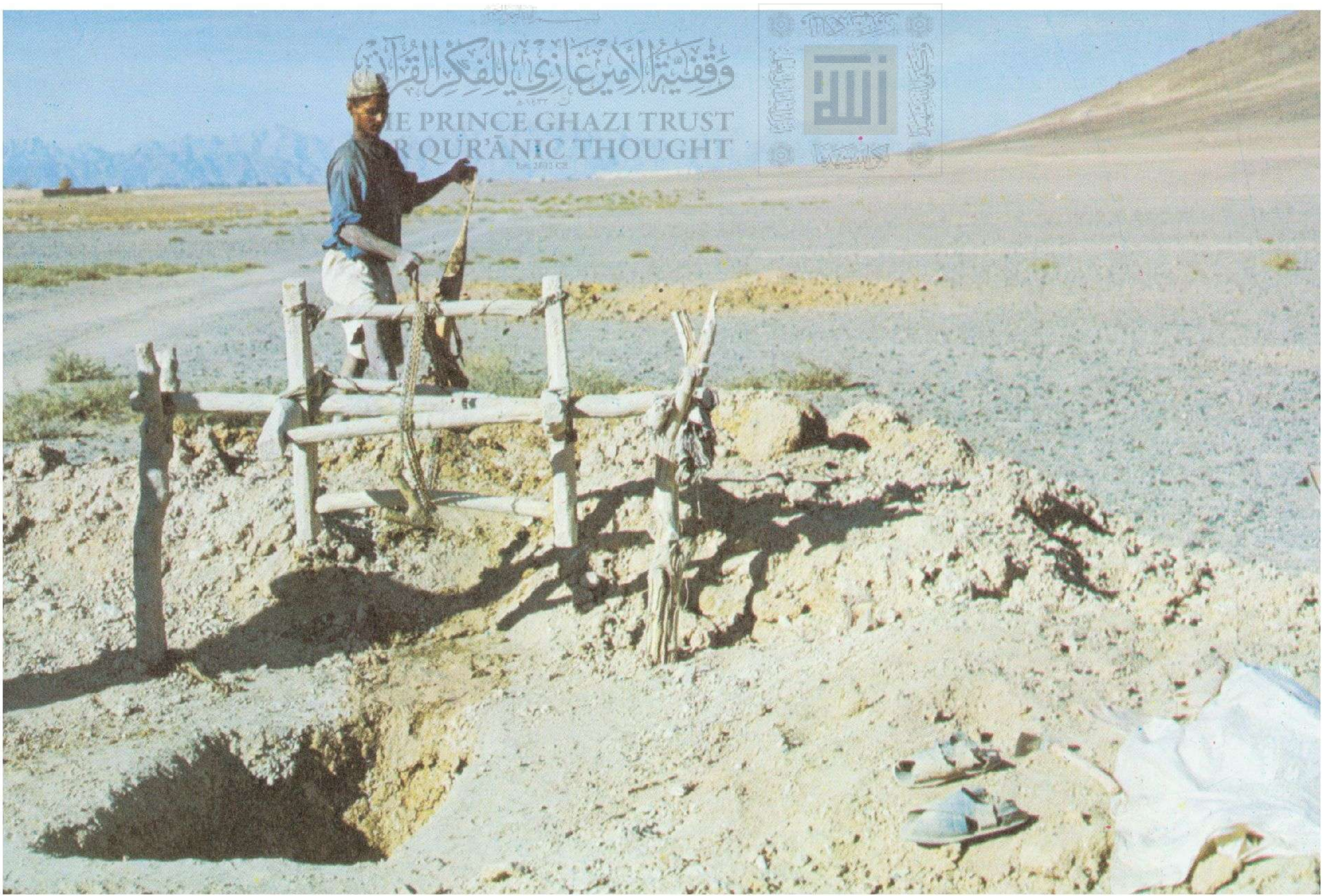
١٤٢ صورة تمثل نظام القنوات أي المجاري المائية تحت الأرض في المناطق الجافة بأفغانستان ولا تزال الطرق القديمة تستخدم حتى الآن في مد القنوات وتنظيمها في فارس وأفغانستان .
