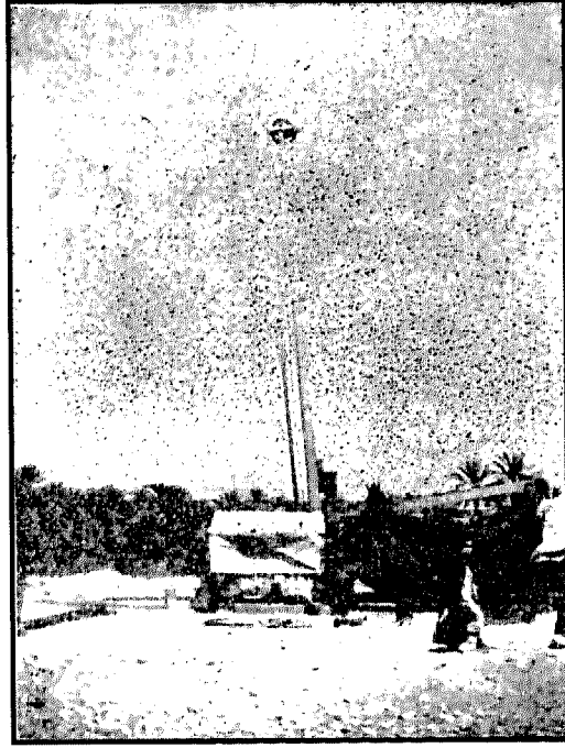
الصورة رقم (٤٧) آلة حفر بئر الماء أمام قصر البديعة
